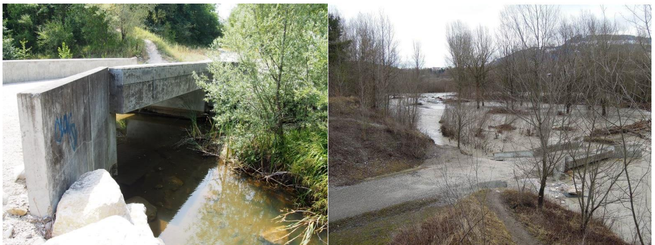
Figure 26 : Photographie du pont cadre actuellement présent dans le vallon du Fier Gauche : vue depuis l'amont (source : BURGEAP 2020) ; droite : vue depuis l'aval rive droite durant la crue de janvier 2018 (source : Grand Annecy)
